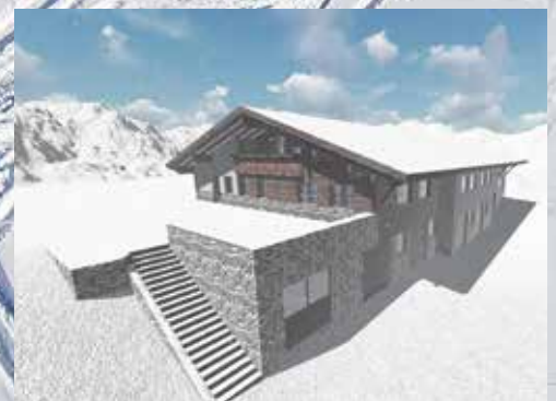
Oben: Beginn der Bauarbeiten des neuen Gebäudes am Gampen Unten: Planungsansicht – das Restaurant befindet sich über dem Stallungsbereich.
