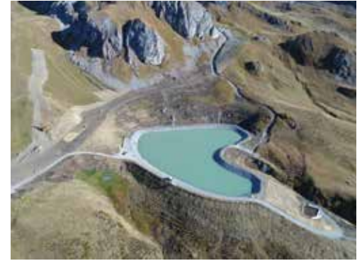
Befüllung des neuen Speichers am 5. Oktober. 5 Tage später war der Speicher voll.
