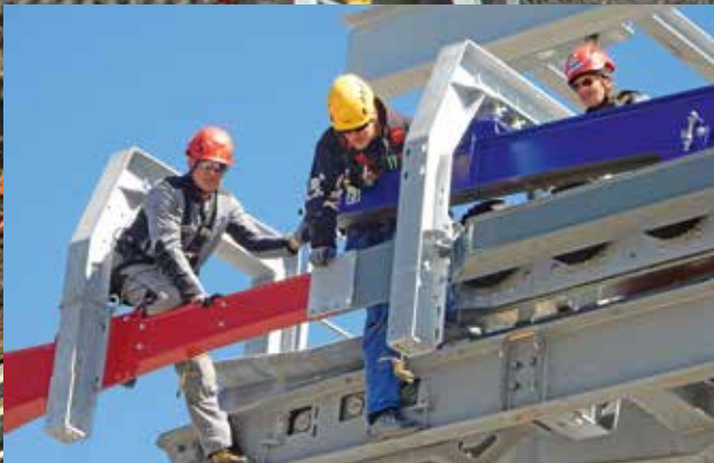
Die Mitarbeiter der Silvrettaseilbahn AG, (von links) Günther Wille, Michael Matt und Manfred Bros bei der Montage der Seilbahntechnik.
