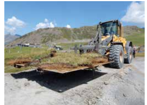
Am 10. Oktober konnten auch die Begrünungsarbeiten abgeschlossen werden.
