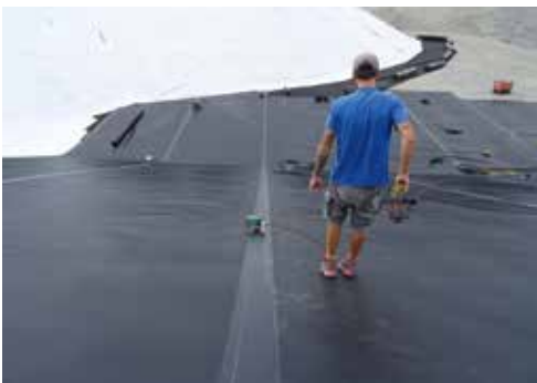
Direkt auf dem weißen Drainagevlies (hinten) liegt die schwarze Spezialfolie, die hier verschweißt wird.
