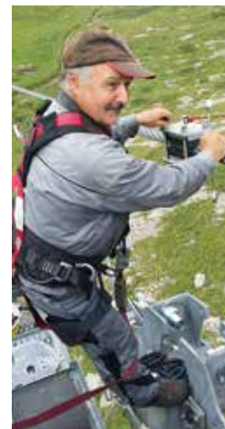
Hans bei Revisionsarbeiten
