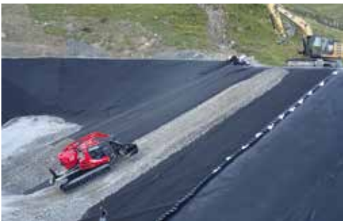
Auf der Spezialfolie liegt ein gepolstertes Schutzvlies. Darauf wird hier mit dem Pistengerät der Kies aufgebracht.
